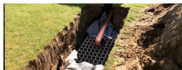
Faskine opbygget af plastkassetter.
