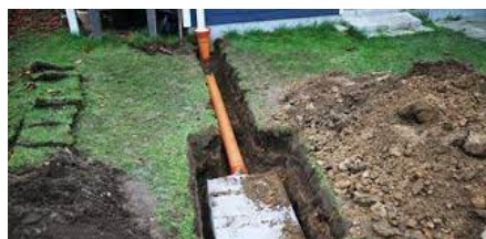
Nedgravning af faskine.
