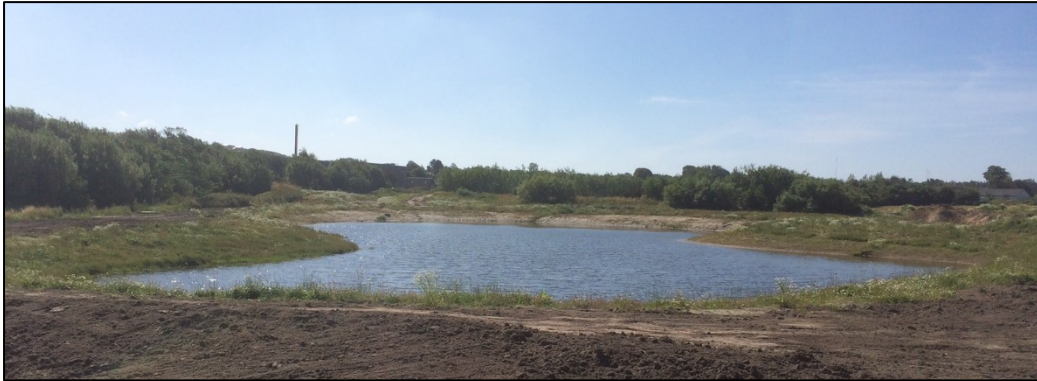
Eksempel på regnvandsbassin. Bassinet er anlagt i Tårs.
