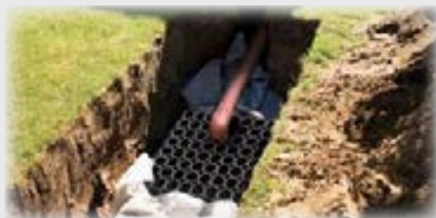
Faskine opbygget af plastkassetter.
