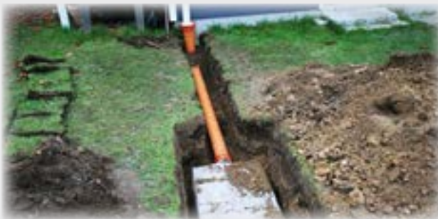
Nedgravning af faskine.
