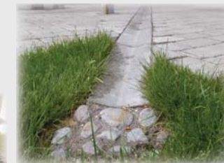
Rende leder vandet ud på græsplænen til nedsivning.
