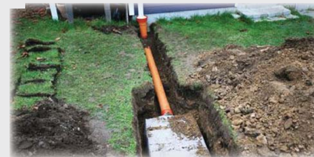
Nedgravning af faskine.
