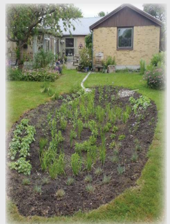
Nedsivning i regnbede og faskine
