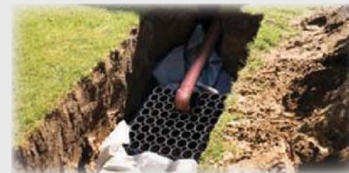
Faskine opbygget af plastkassetter.
