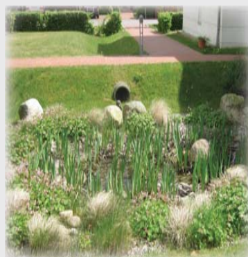
Eksempel på regnbed med skjult rør
